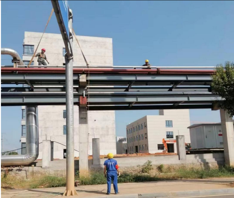
图 4-1 项目建设期间照片
