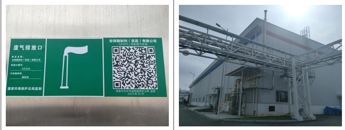
DA005 排气筒排放口标识及排气筒照片
