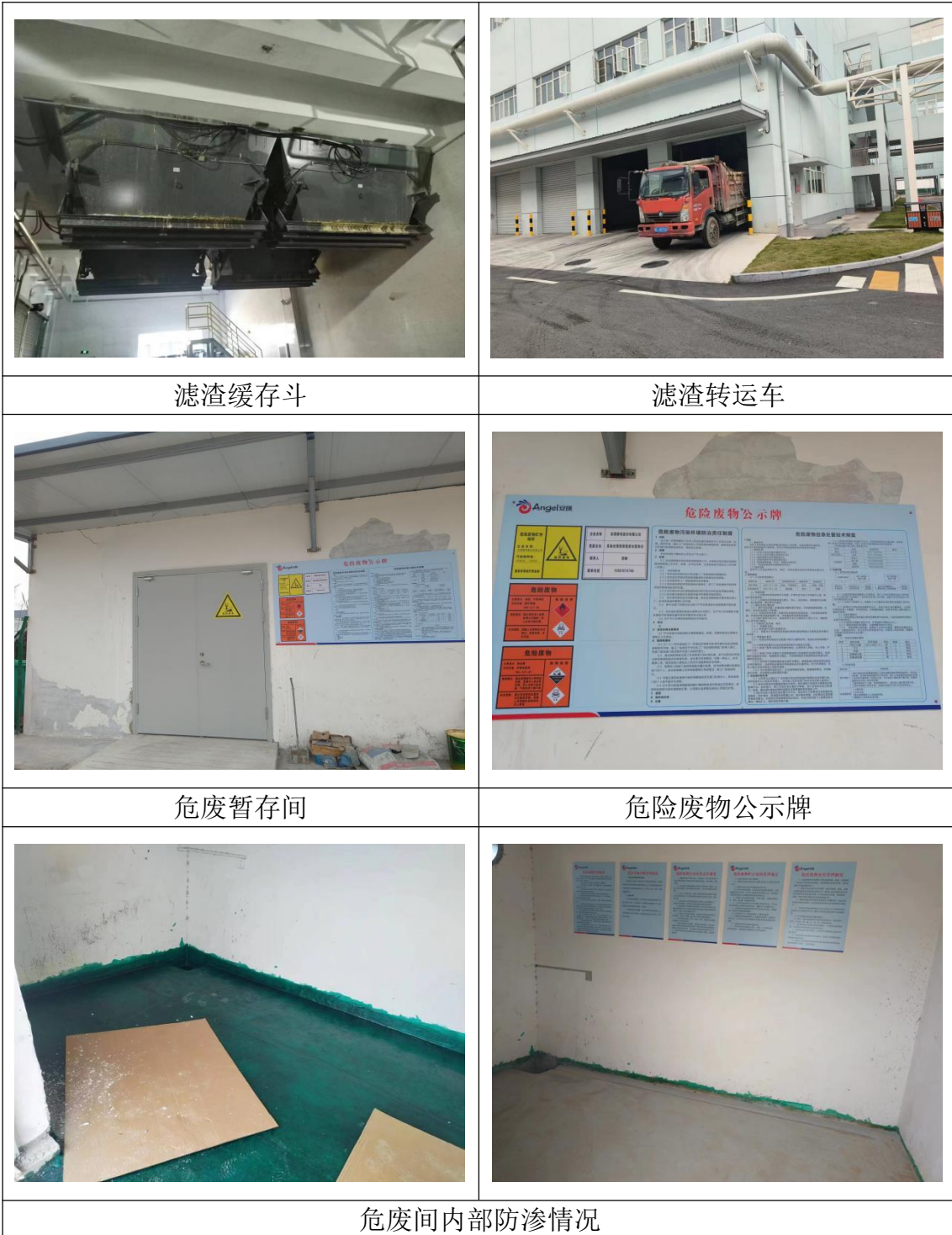
图 4.1-7 项目危废暂存间建设情况
