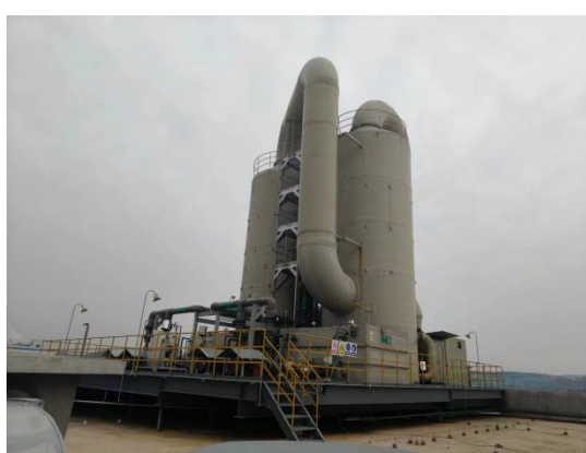
旋风分离器+水膜除尘器+二级水喷淋（喷雾干燥塔-干燥废气）
