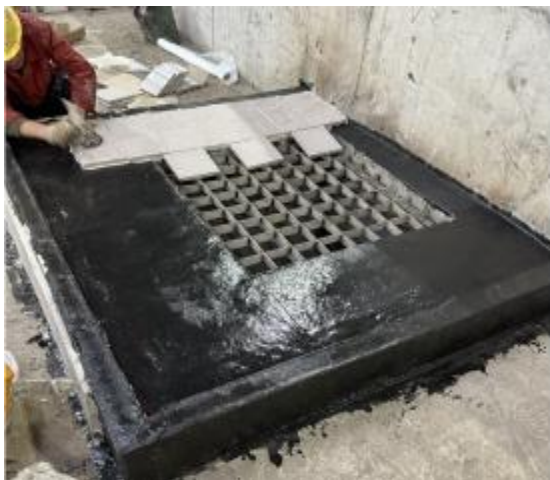
项目施工防渗照片
