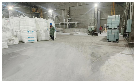
原料仓库内部地面硬化情况
