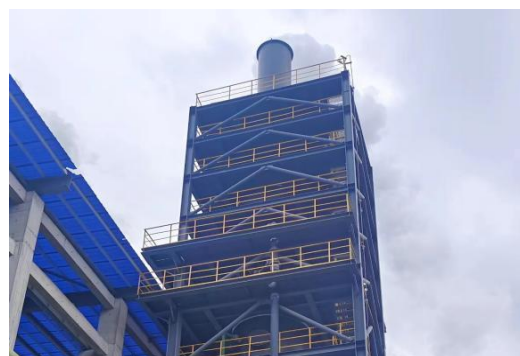
DA090 排气筒采样平台照片
