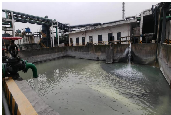
全厂雨水收集池
