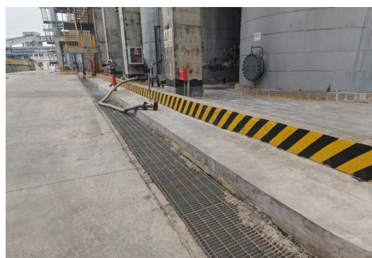
生产区外防渗照片
