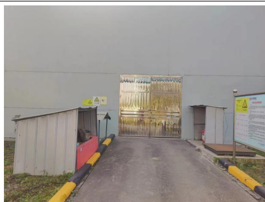
危废间外部照片
