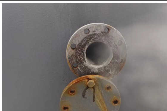
DA090 排气筒采样口
