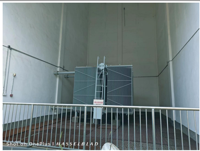
变电站主变压器
