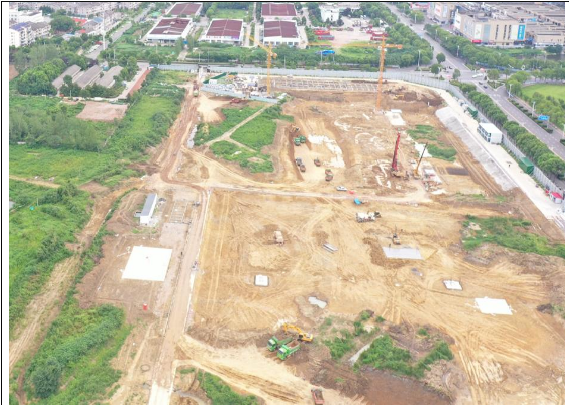
图3.4-1 西侧相邻地块现状
