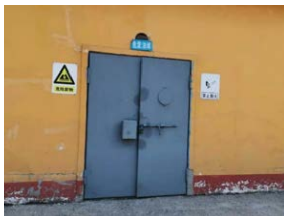
图 3.2-12 中央采区危废暂存间
