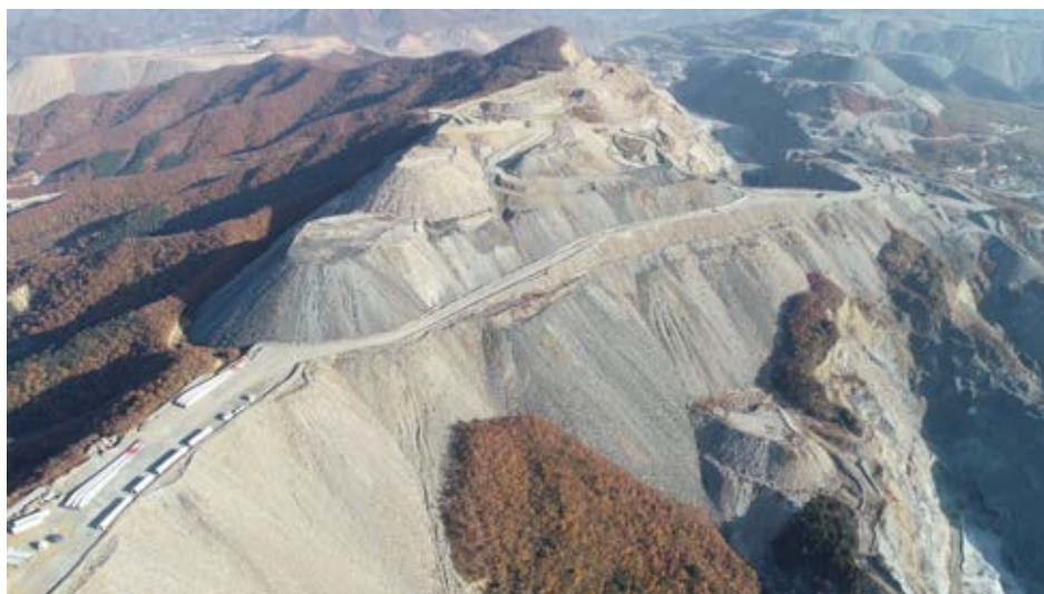
图 3.2-1 后台沟废石场
