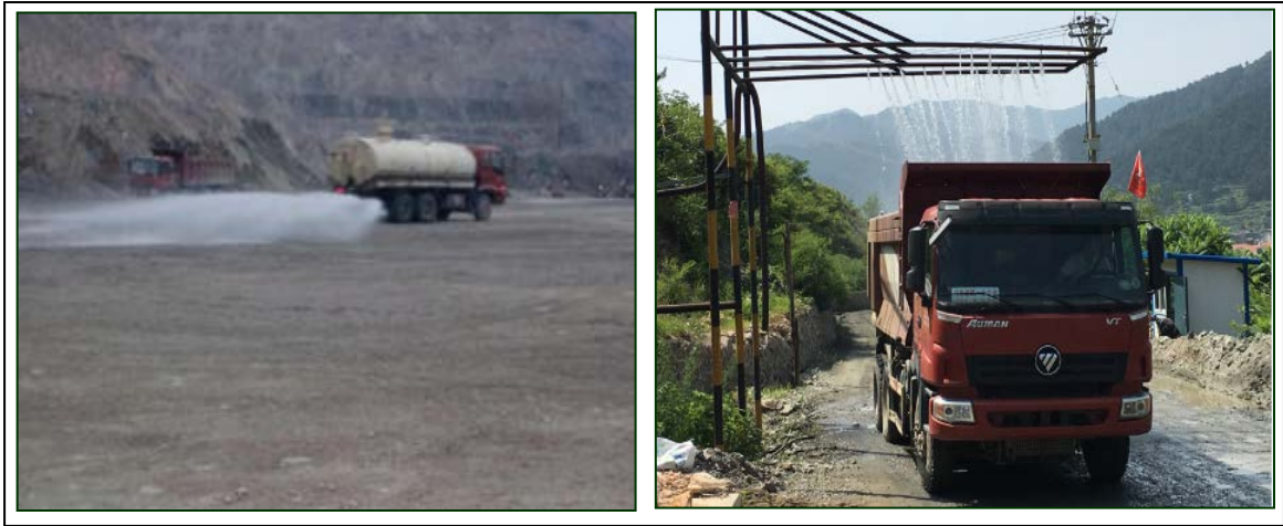
图 3.4-3 地表降尘洒水、翻车前车辆喷洒水设施现场图
