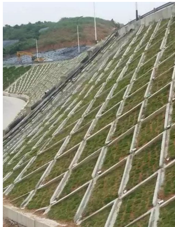
边坡安全监测
