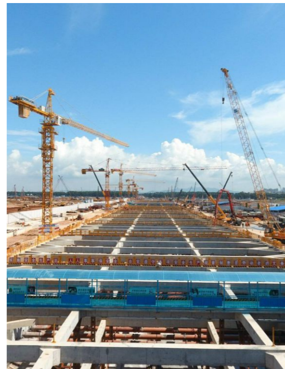
地铁基坑安全监测
