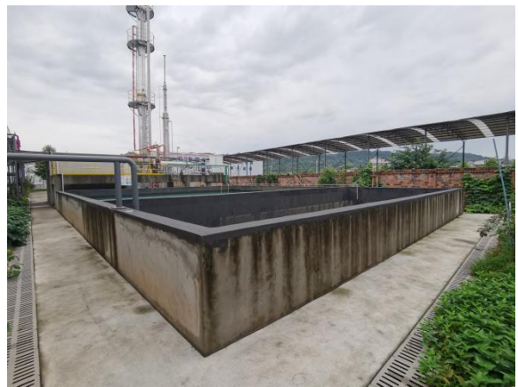
氨氮处理池（未投入使用）
