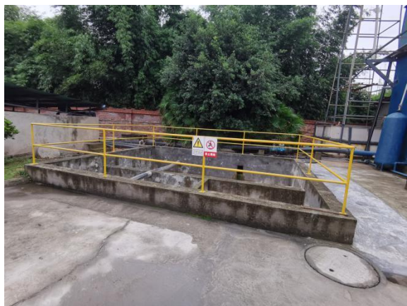
初期雨水处理池
