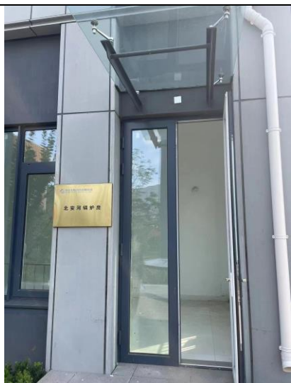
项目锅炉房外观
