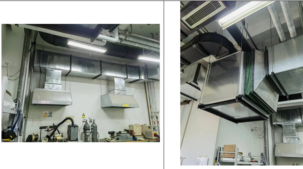
图 3-1 本项目转子车间焊接废气处理装置
