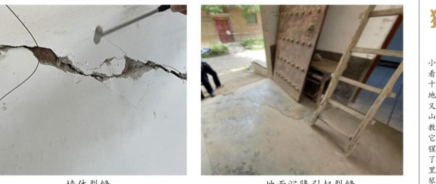
(2) 细部构造：墙面不按规范设置防潮层，水分渗入墙体，造成房屋墙面抹灰层脱落，甚至造成砖的剥蚀；厨房、卫生间防水措施处理不当；房屋楼板若使用预制板，施工过程中在板上凿洞，造成使用过程中大面积渗水、漏水。
