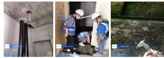
蓄水验收无渗漏 精装修防水验收 精装修防水验收
