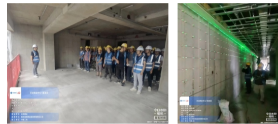
组织精装修人员学习交底 墙而木基层施工
