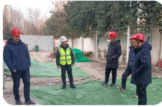
2月2日上午，经发会馆拆除项目部联合建设单位、施工单位相关管理人员对施工现场进行了复工前的安全检查。
