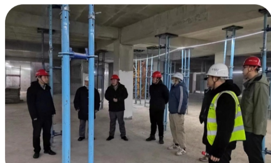
2月14日上午，第八十九项目部会同建设单位组织各总包单位项目经理、技术总工、质量员等对项目的车库顶板、外墙及主楼屋面进行防渗漏专项排查。
