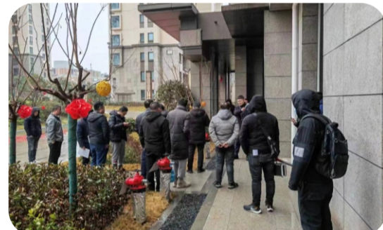
2月13日上午，宝鸡吾悦广场项目进行消防专项工程验收，质监站、建设单位、设计单位、监理单位、施工单位及各分包单位参加了会议。
