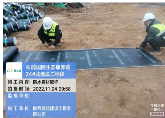
朱鹏国际生态康养城 24#北地块二标段 施工内容：防水卷材取样 拍摄时间：2022.11.04 09:58 监理单位：陕西建朝建设工程有限公司
