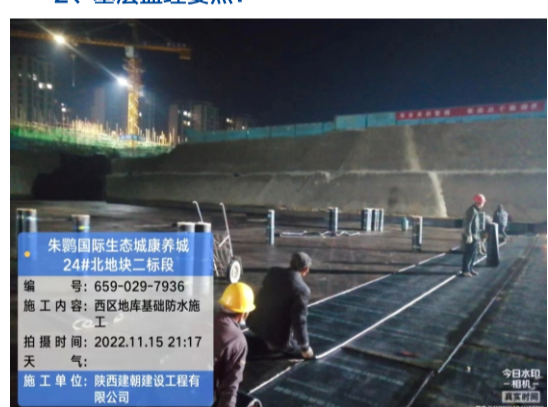
朱鹏国际生态康养城 24#北地块二标段 施工内容：西地区库基础防水施工 拍摄时间：2022.11.15 21:17 监理单位：陕西建朝建设工程有限公司
