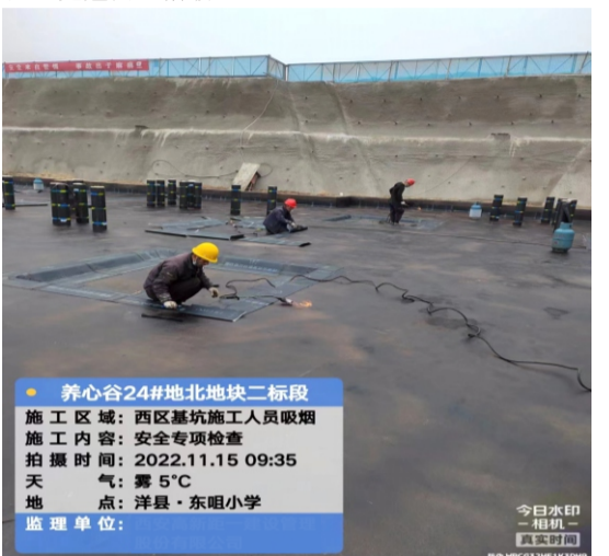
养心谷24#北地块二标段 施工内容：西地区库基础防水施工 拍摄时间：2022.11.15 09:35 天气：雾 5℃ 地点：洋县·东旭小学 监理单位：陕西建朝建设工程有限公司
