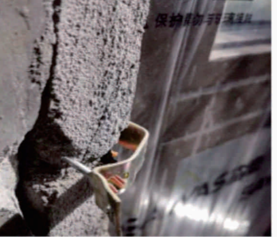
图示：钢片连接件直接用射钉固定在砌体上 文/司法鉴定中心 刘芳
