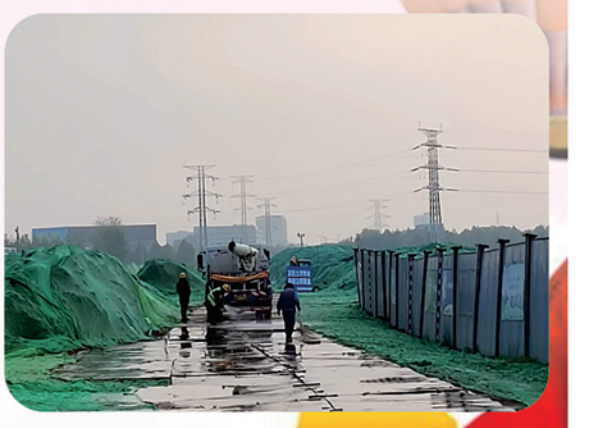
港务南路项目监理部严格要求施工单位落实“六个百分百、七个到位”文明工地。
