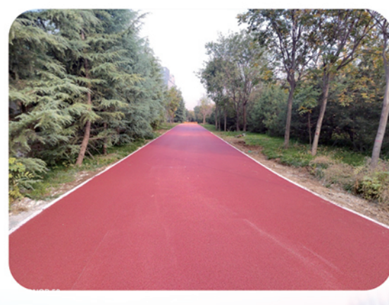
市政工程处第五项目部承监的西三环（科技八路至天谷八路）自行车道工程顺利完成。
