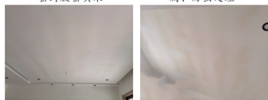
吊顶乳胶漆泛黄
