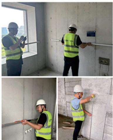
随着工程进度实施，各主楼已陆续封顶，按照监理部工作要求并结合“监理+”拓展要求，项目部对具备实测条件的所有楼层进行了全数测量，并在实测混凝土强度、墙面垂直度及平整度的基础上，增加了ALC和砌体墙面垂直度及平整度测量。对进场材料、工序等实测均落实在日常监理过程中，在月度实测报告中予以体现。
