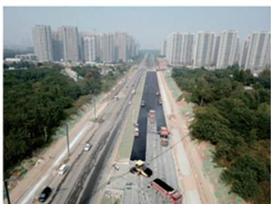
我司承监的兴隆一路、三星大道北延伸段，经过2个多月的日夜奋斗，项目监理部结合“监理+工具平台应用”（无人机应用），重点聚焦进度控制方面。在项目施工过程中，坚持每周飞行三次，及时了解各工作面、材、机的投用情况及施工进度情况，每日下班前召开现场碰头会议，指出拍摄中存在的进度、质量、文明施工等问题，并督促总包单位及时整改完善。过程中辅助“监理+”工具平台应用（无人机应用）的使用，能直观地对施工进度进行阶段性对比，提前预控进度滞后的情况。
