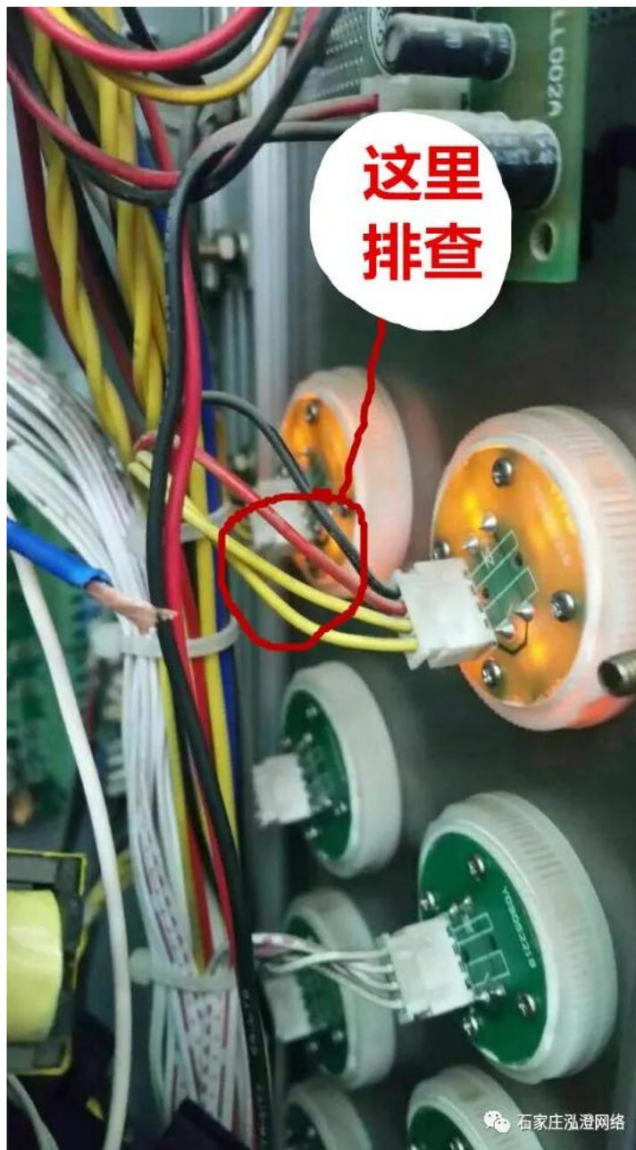
电梯呼叫按钮出现 4 根线时，容易引起自动呼叫 因：4 线中 2 线为灯带电源线，使呼叫按钮 L、R 信号带电引起自动呼叫，解决方法如下
