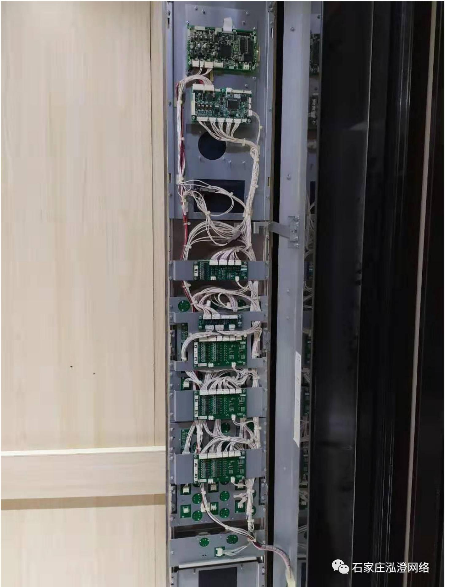
找到操作盘空闲的 COM 口，通过六匹线连接转接板与操作盘。
