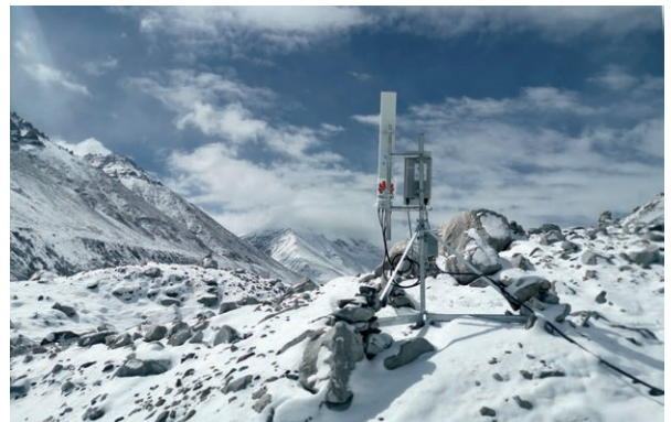
■ 华为5G极简基站，实现珠峰千兆网络全覆盖
