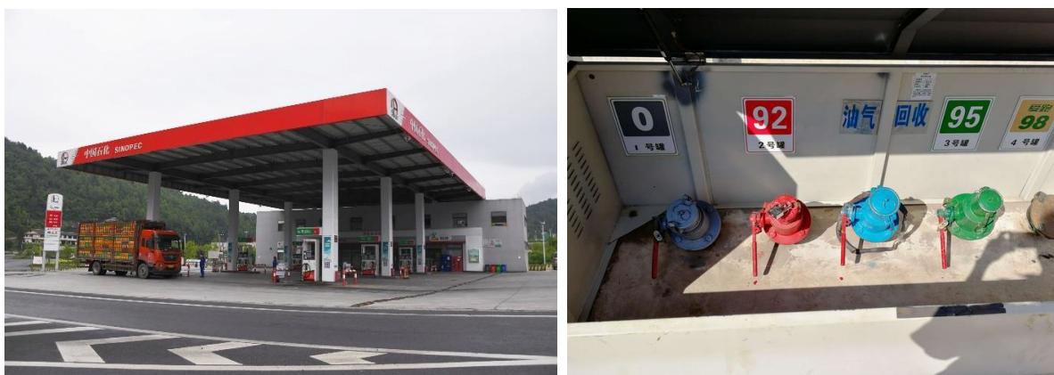
▲ 加油站加油区和卸油区
