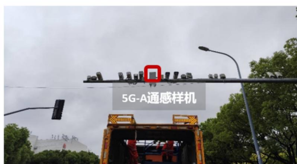
图3.18 5G-A通感样机路侧安装示意图
