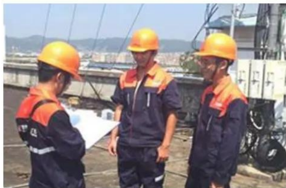
广西电信皮基站及直放站项目工程总包 3400万元
