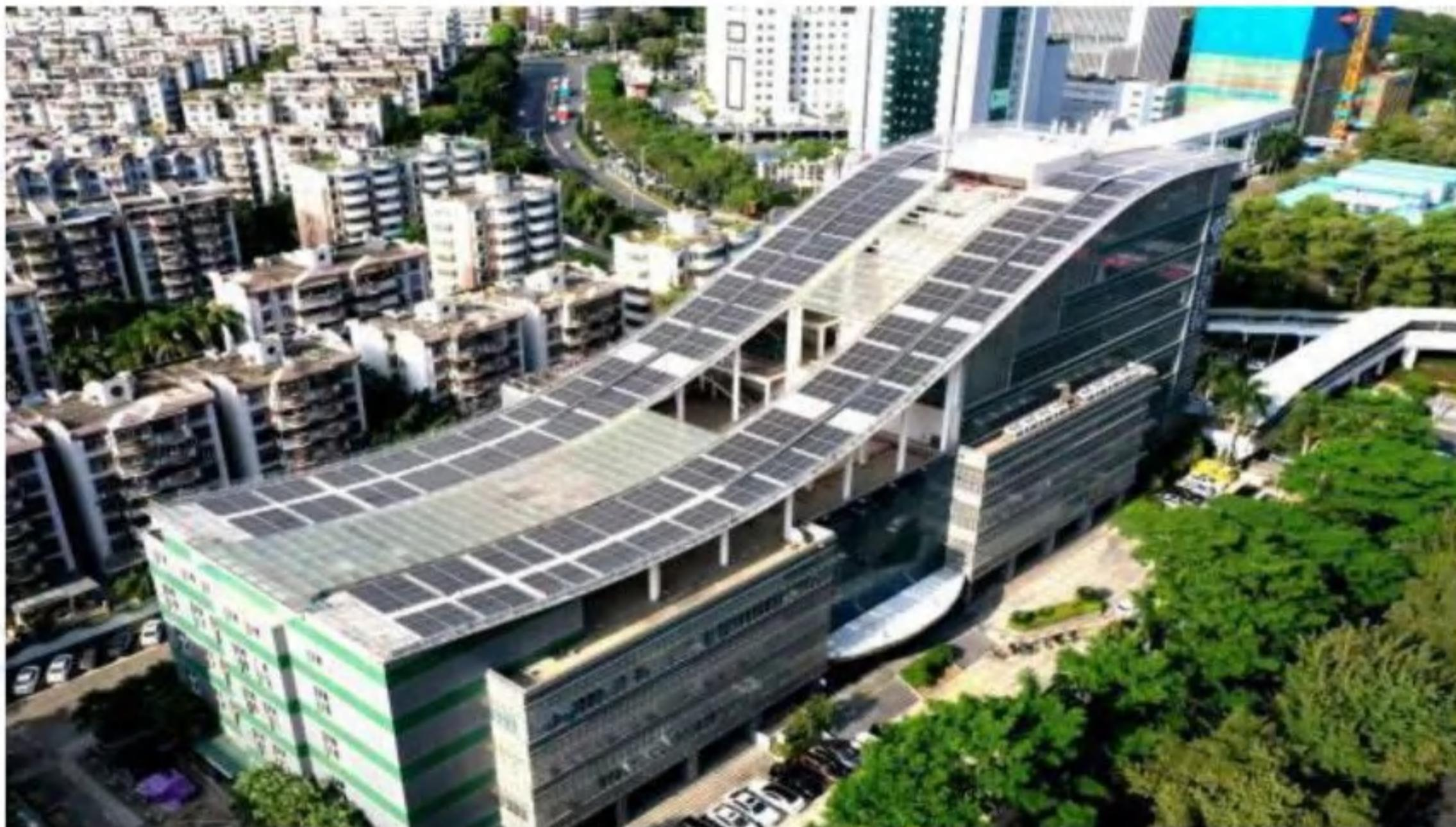
图 1 深圳电信某枢纽机楼光伏并网系统
