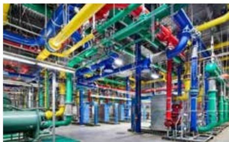
谷歌俄勒冈州数据中心管道、桥架和线缆的配色 (图片来源互联网)
