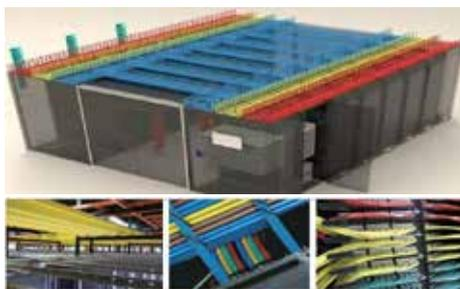
国内某电信数据中心桥架和线缆的配色 (图片来源互联网)
