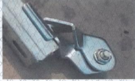
图1 抗震连接部件
