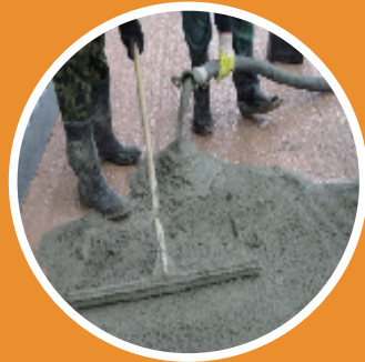
5. 面层砂浆泵送
