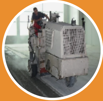
1. 铣刨机处理基面 原有混凝土
