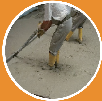
6. 面层砂浆摊铺
