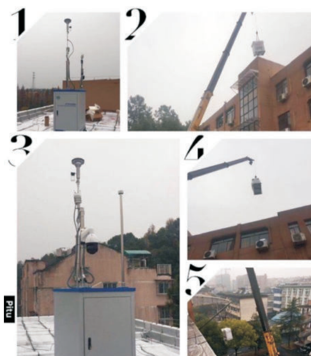
余杭 余杭街道
