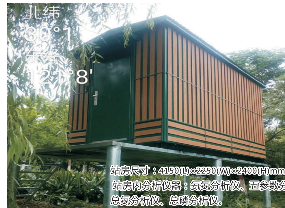
余姚环保局沈家闸水质监测站房
