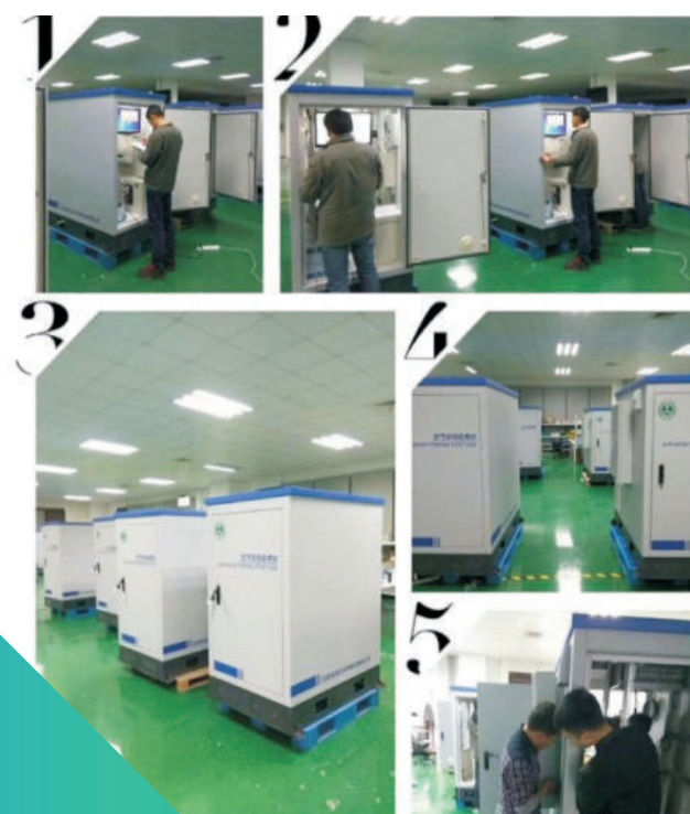
杭州大气项目生产调试中
