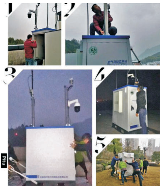
杭州大气项目现场安装调试
