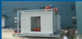
舱塔一体化集成舱安装
