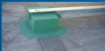
钢墩基础锚固及防腐处理
