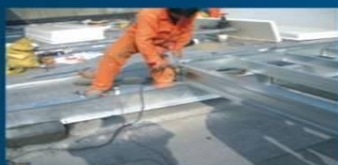
组合式轻钢结构机房钢网基础安装
