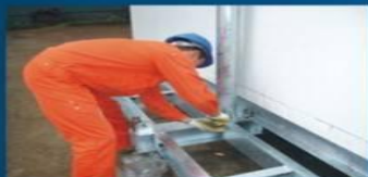
舱塔一体化集成舱安装
