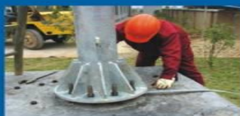
通信杆塔调测
