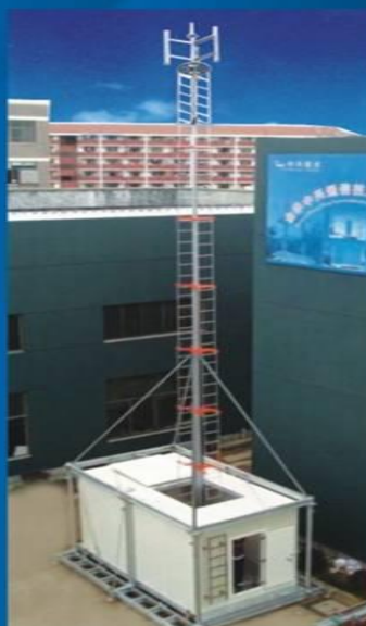
舱塔一体化集成舱安装完成
