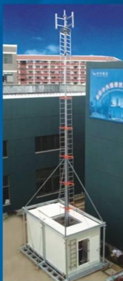
舱塔一体化集成舱安装完成
