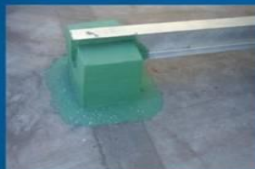
钢墩基础锚固及防测处理
