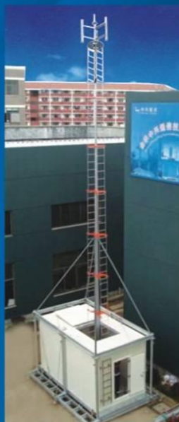
舱塔一体化集成舱安装完成
