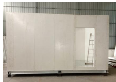
步骤三：墙板安装
