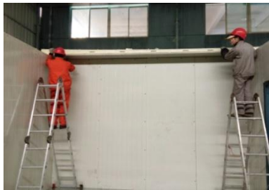
步骤五：顶板铺设
