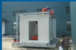
舱塔一体化集成舱安装
