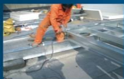
组合式轻钢结构机房网架基础安装
