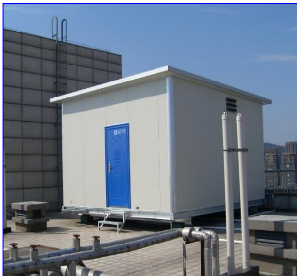
楼顶六面体机房
