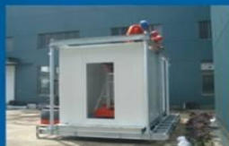
舱塔一体化集成舱安装
