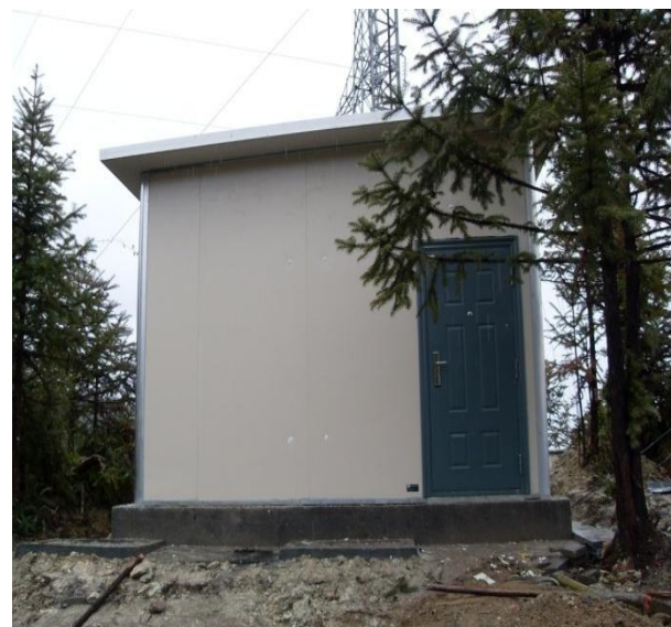
落地五面体机房
