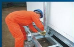
舱塔一体化集成舱安装
