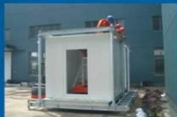
舱塔一体化集成舱安装
