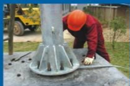
通信杆塔调测
