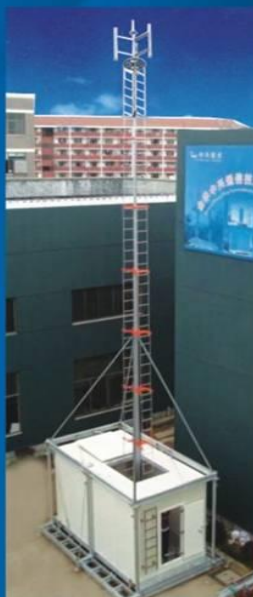
舱塔一体化集成舱安装完成
