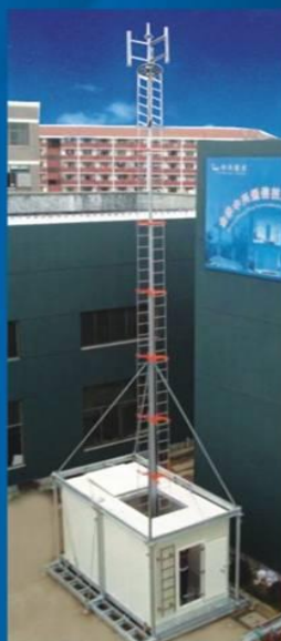
舱塔一体化集成舱安装完成
