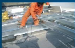
组合式轻钢结构机房网架基础安装
