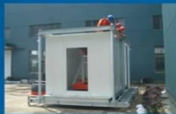
舱塔一体化集成舱安装
