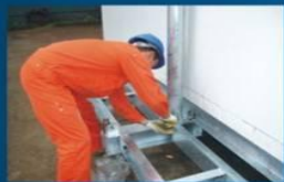
舱塔一体化集成舱安装
