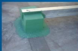
钢墩基础浇筑及防腐处理
