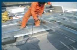
组合式轻钢结构机房钢网基础安装
