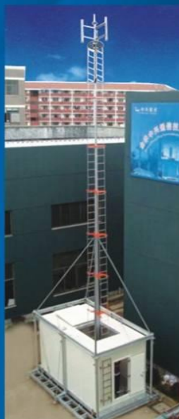
舱塔一体化集成舱安装完成
