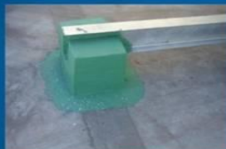
钢网基础锚固及防测处理
