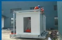
舱塔一体化集成舱安装
