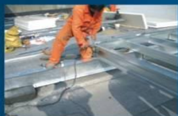
组合式轻钢结构机房钢网基础安装
