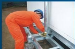
舱塔一体化集成舱安装
