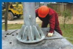
通信杆塔调测
