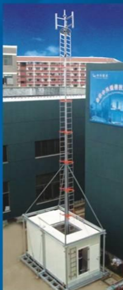
舱塔一体化集成舱安装完成
