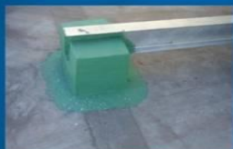
钢墩基础锚固及防腐处理
