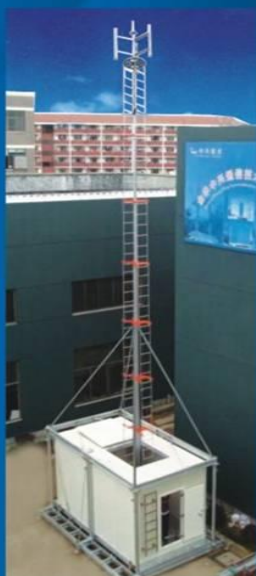
舱塔一体化集成舱安装完成
