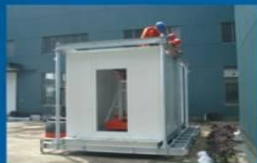
舱塔一体化集成舱安装
