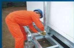
舱塔一体化集成舱安装
