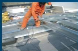
组合式轻钢结构机房网基础安装
