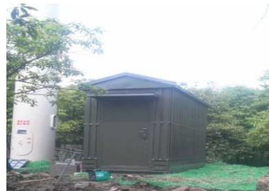
步骤九：安装完成
