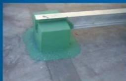
钢墩基础锚固及防腐处理
