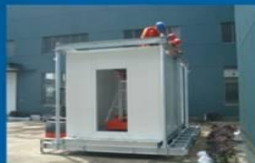
舱塔一体化集成舱安装
