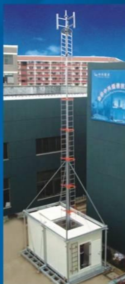
舱塔一体化集成舱安装完成
