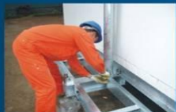
舱塔一体化集成舱安装
