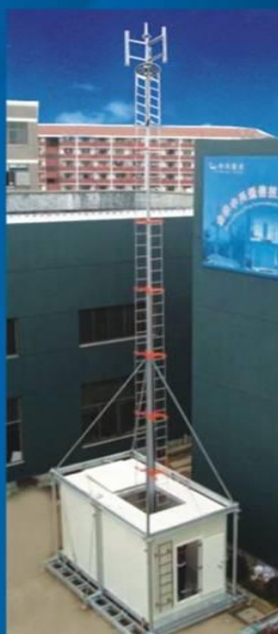
船塔一体化集成舱安装完成
