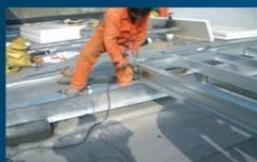
组合式轻钢结构机房网架基础安装
