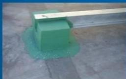
钢墩基础锚固及防腐处理
