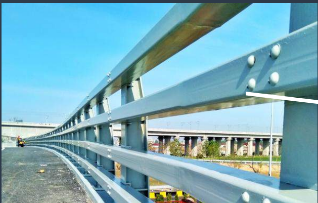
浙江临安省道
