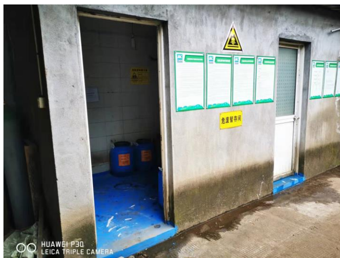
图 6-5 感光材料废物暂存间及管理台账
