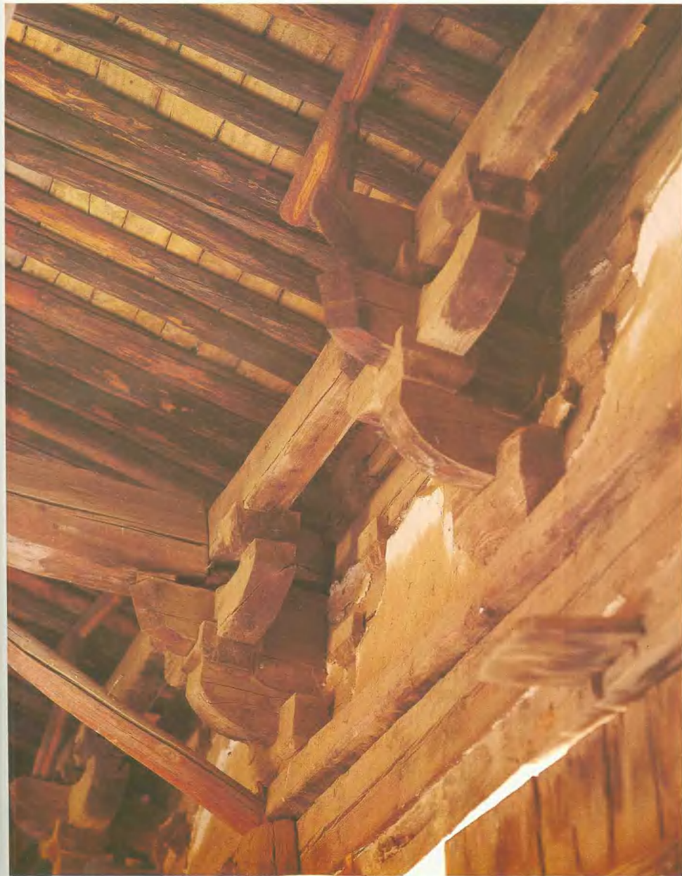
一〇 文殊殿後簷科拱尾部結構
