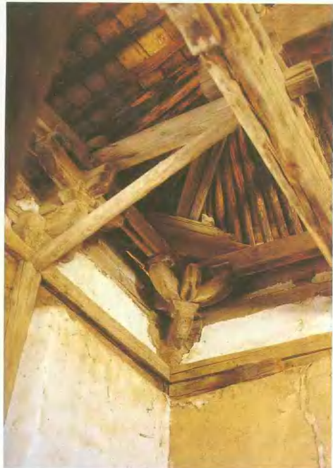
二〇 文殊殿西南轉角尾部結構
