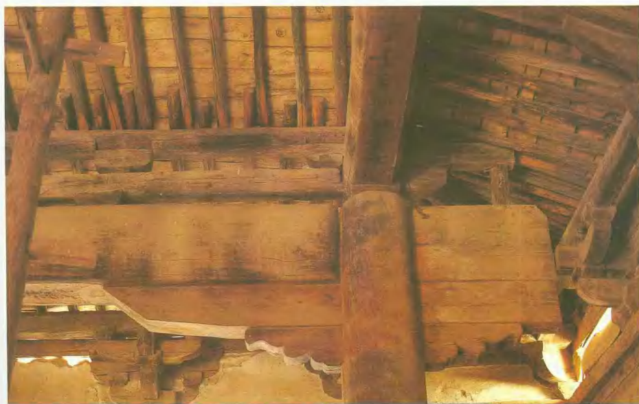
一九 文殊殿後槽東側金柱與額枋結構
