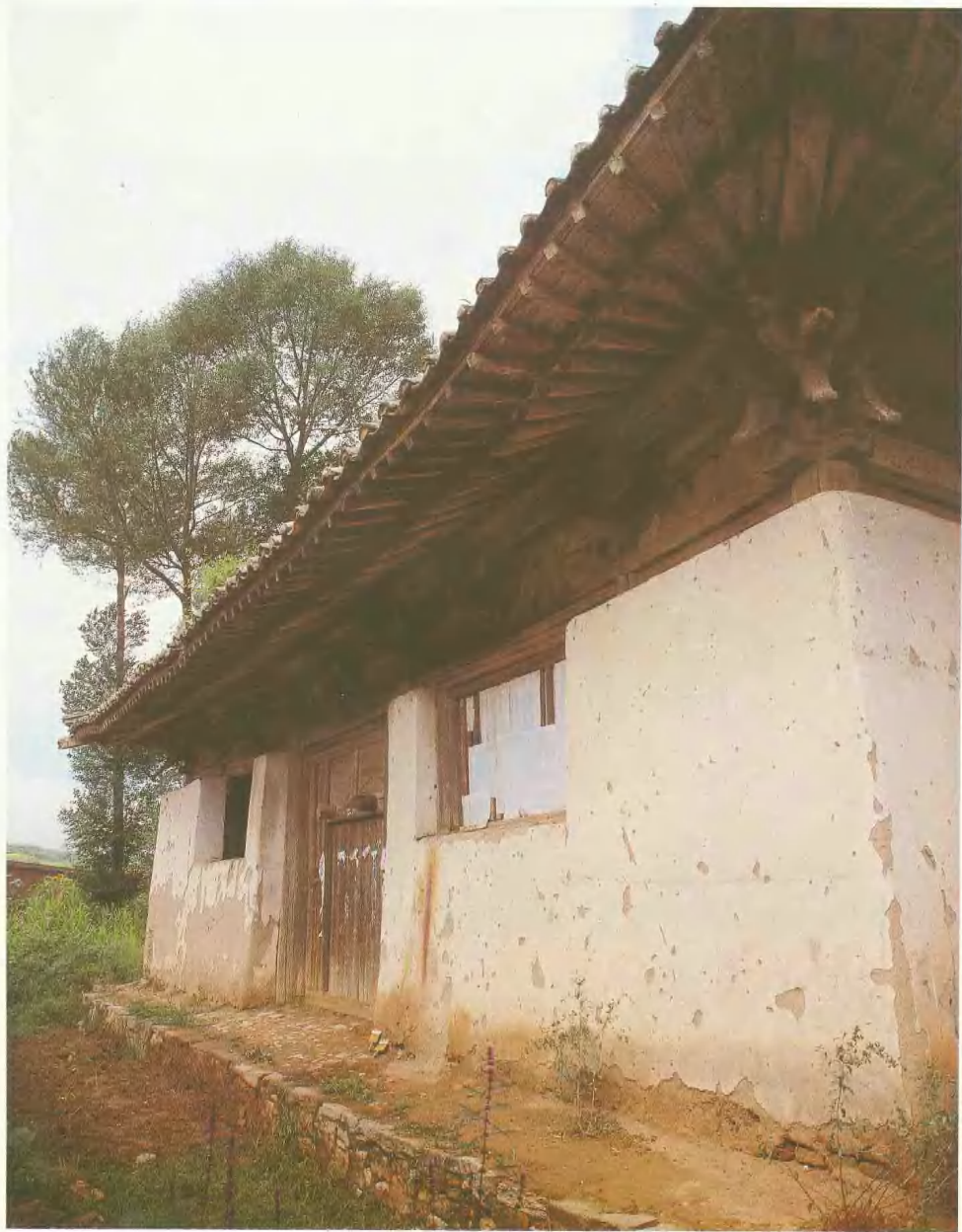
二 巖山寺文殊殿正面近景
