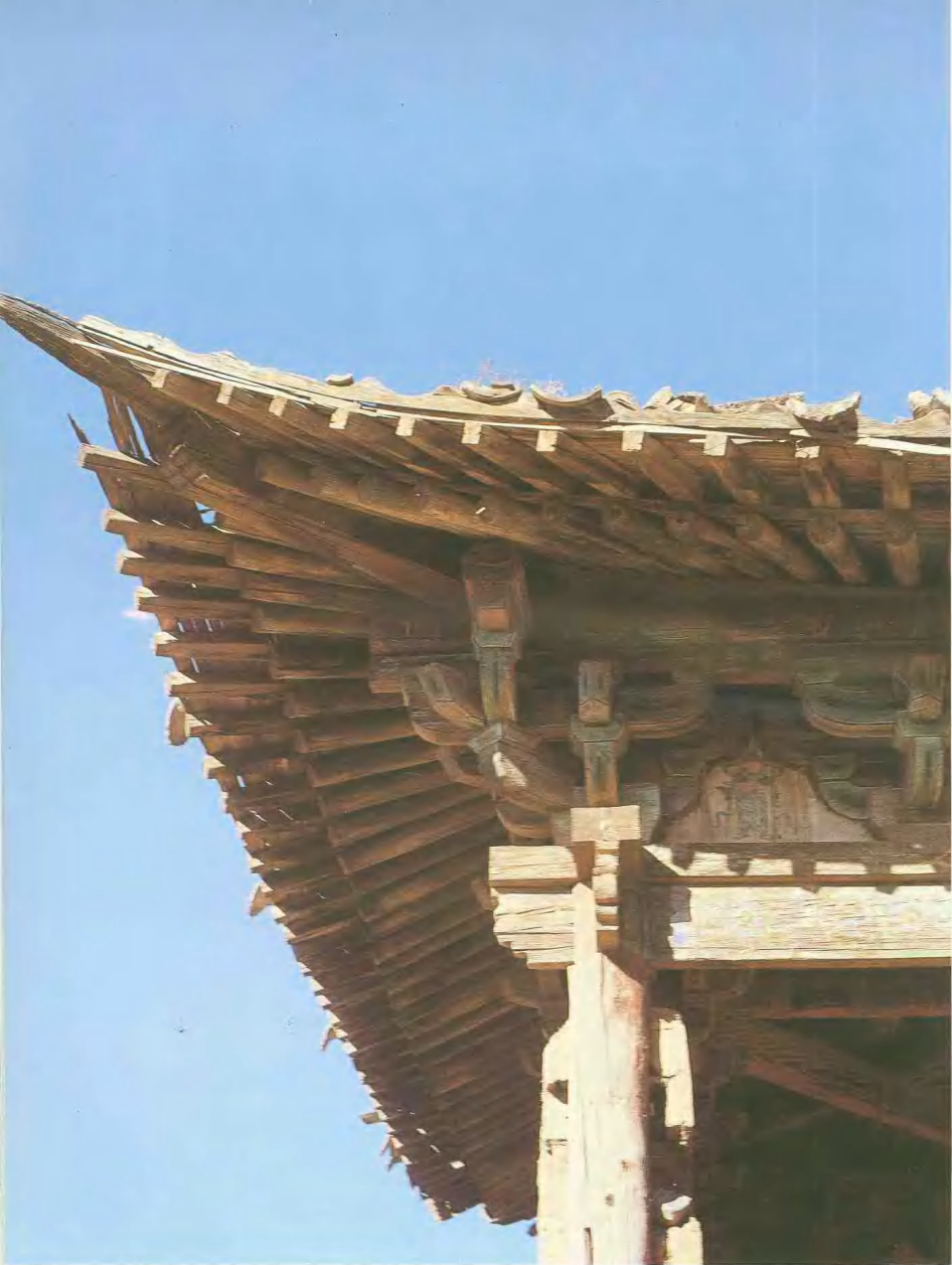
一四二 圓覺殿西南翼角結構
