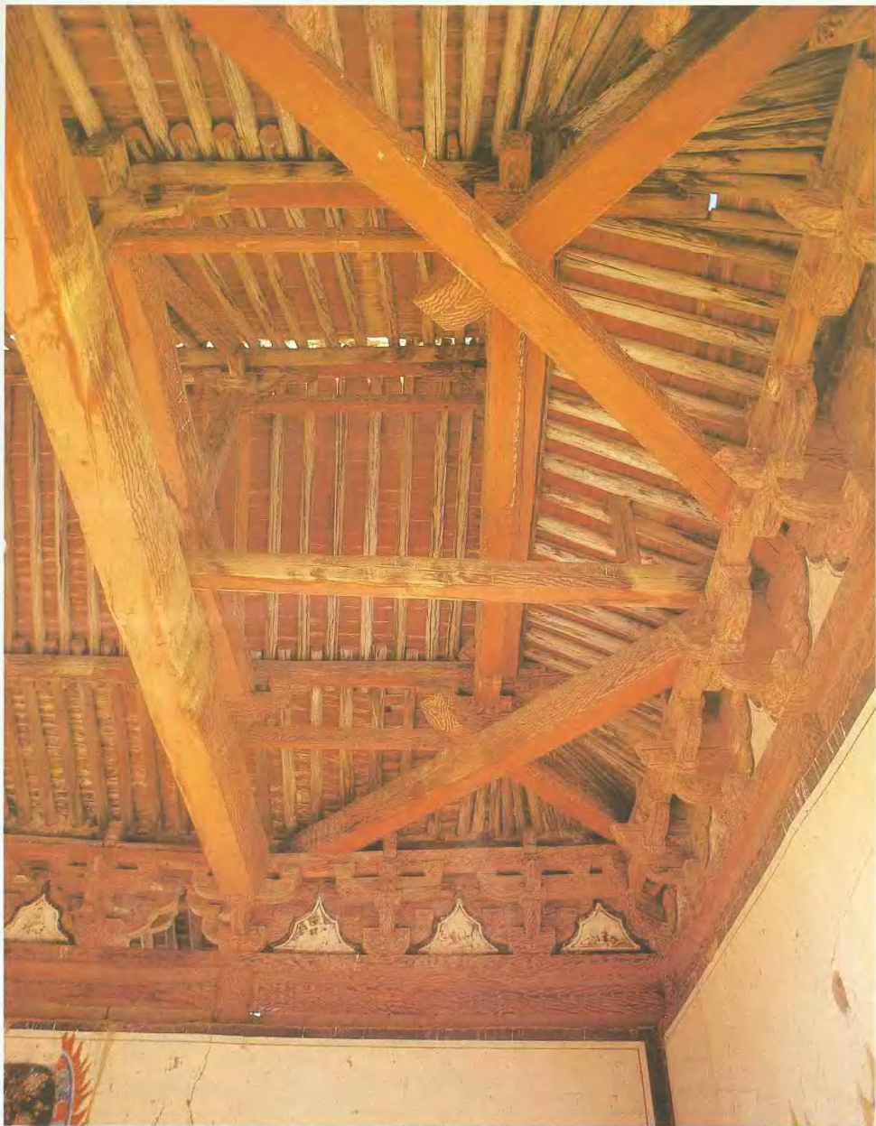
一四七 圓覺殿山面樑架結構
