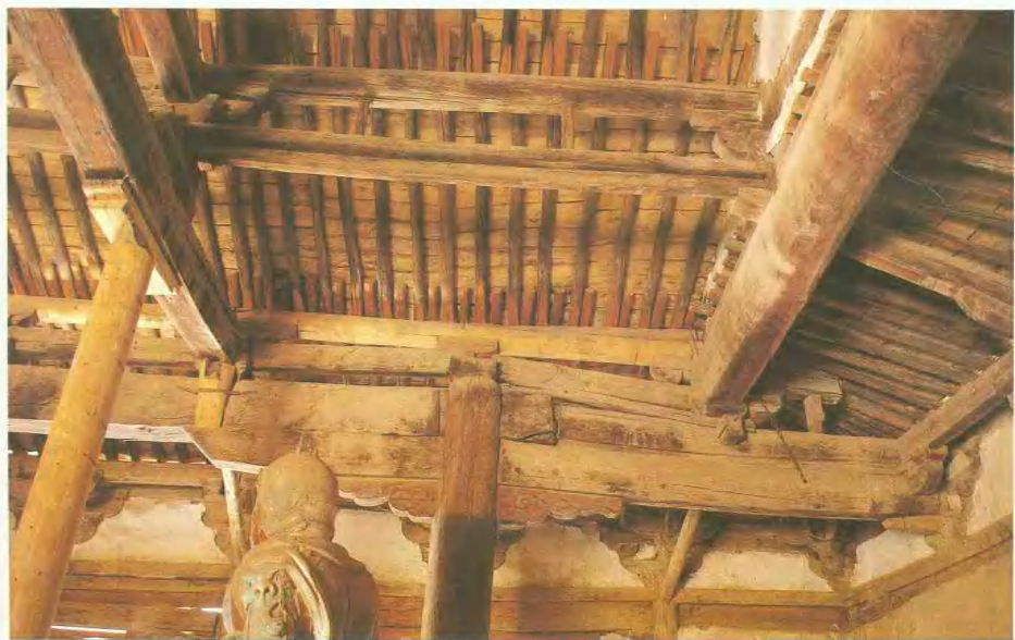
一七 文殊殿前槽西側金柱與額枋結構
