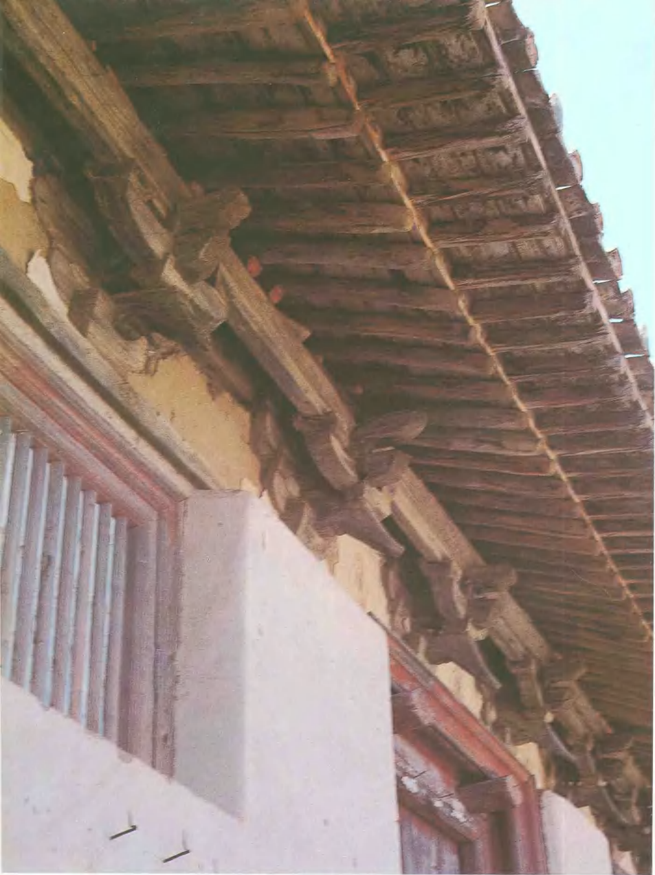
七 文殊殿後簷結構
